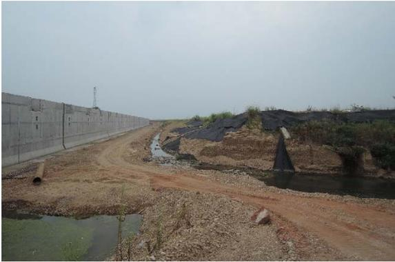
塔底基坑施工临时排水沟
