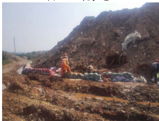
图 4-8 填土草袋围护
