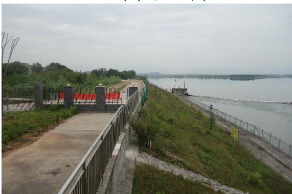
防洪堤草皮护坡
