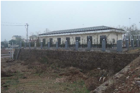
管理区钢丝笼挡墙
