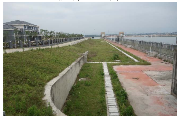
船闸场内道路草皮护坡
