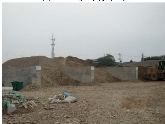
图 4-7 C15 砼挡墙围护
